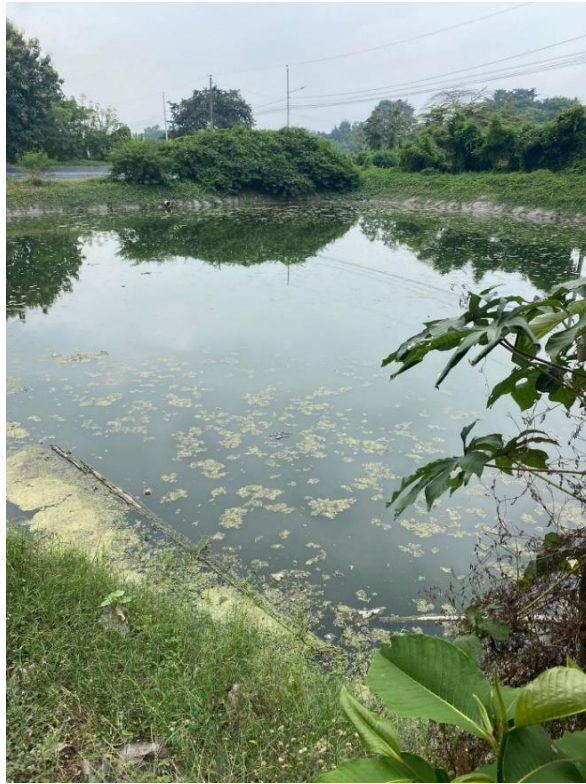
Ilustración 19. Laguna de estabilización Palestina. Fuente: Autor
