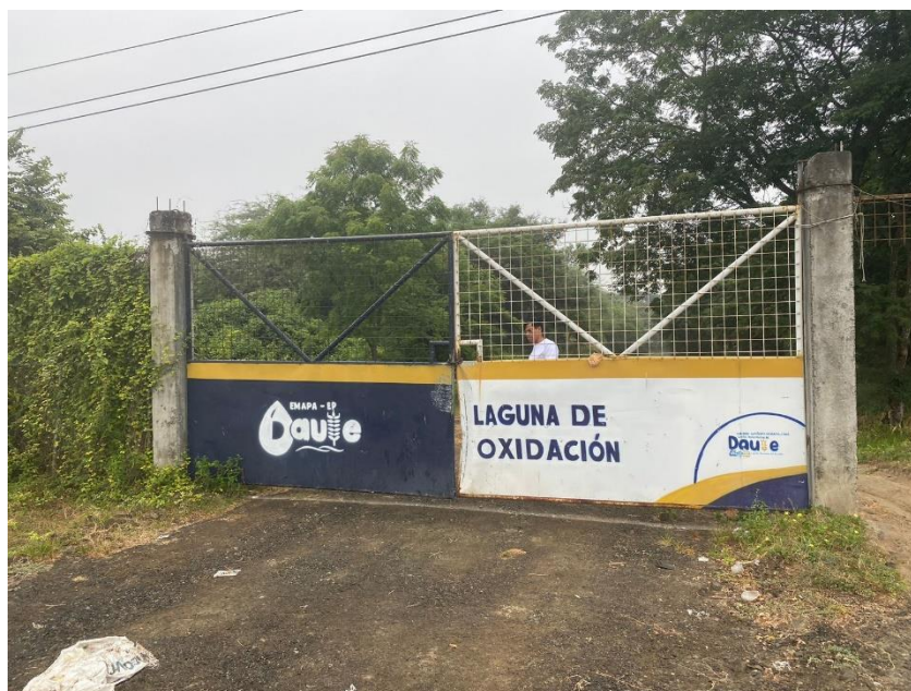
Ilustración 14. Ingreso a la laguna de oxidación Daule. Fuente: Autor.
