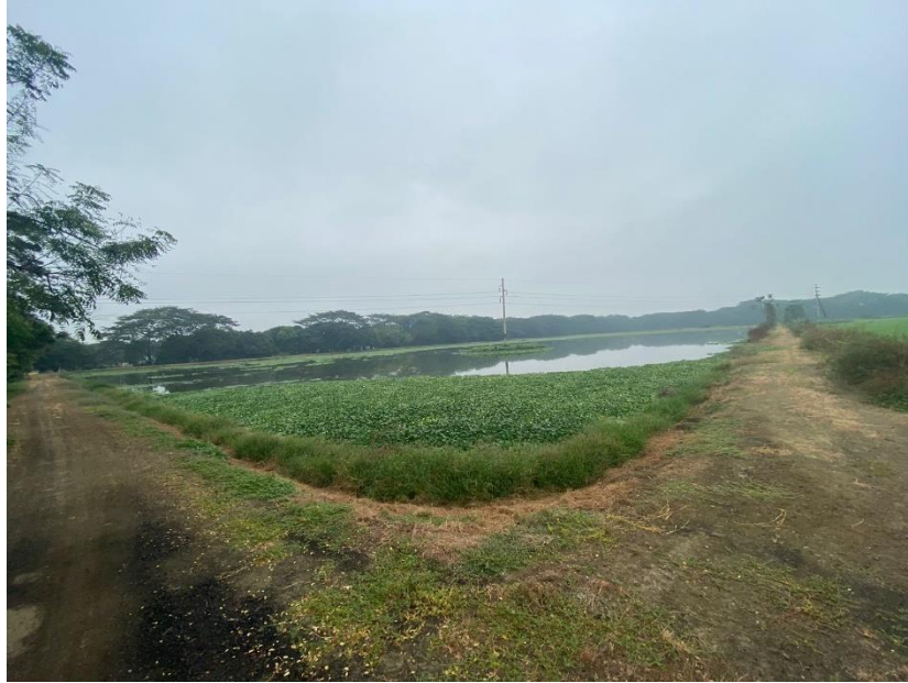
Ilustración 15. Laguna de oxidación Daule. Fuente Autor.
