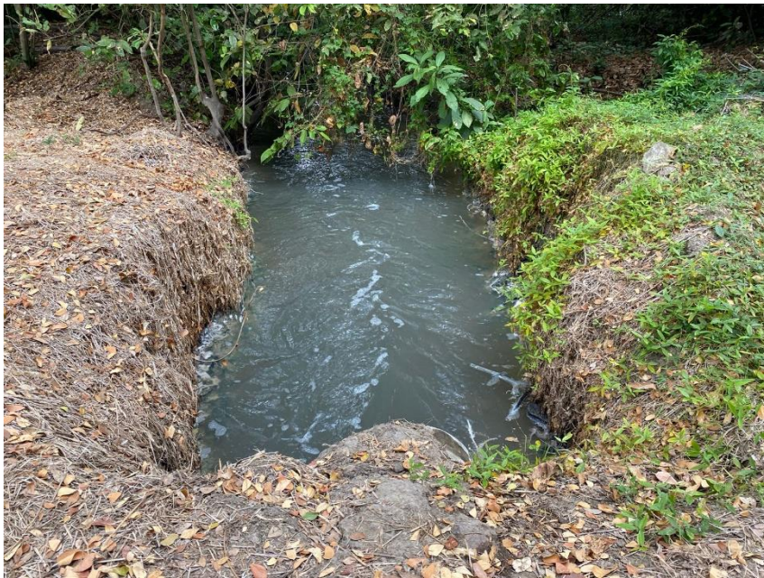
Ilustración 16. Zona de descarga de agua en planta de tratamiento Daule. Fuente: Autor.
