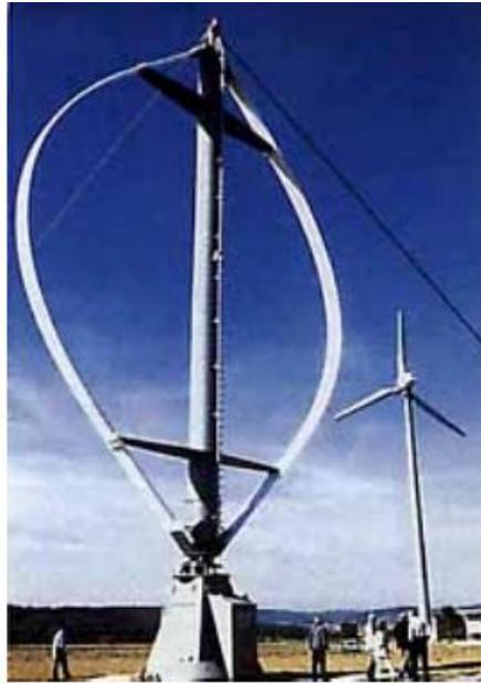
Foto 2 Sistema de Conversión de Energía Eólica de Eje Vertical
