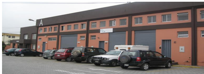
Figura 9. Instalaciones Distribuidora S&E
