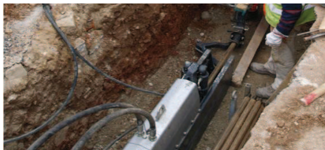
Imagen 11. Máquina hidráulica de fuerza para halado
