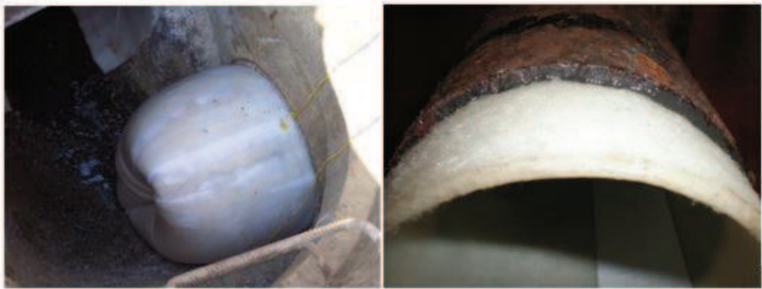
Imagen 26 Técnica sin Zanja CIPP.
