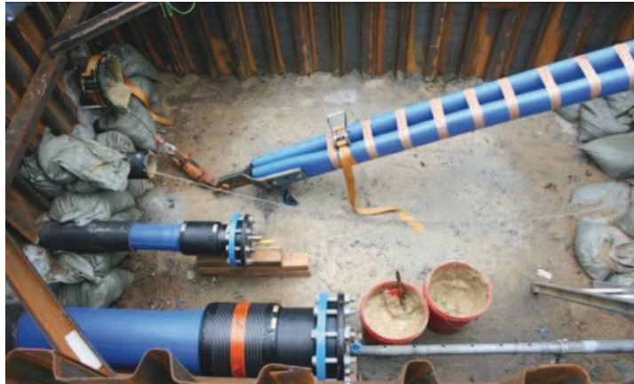
Imagen 21. Proceso de rehabilitación de redes mediante Close Fit.
