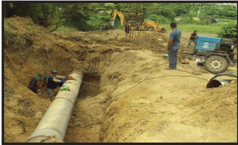
Imagen 1. REPARACIÓN DE TUBERIA CON ZANJA
