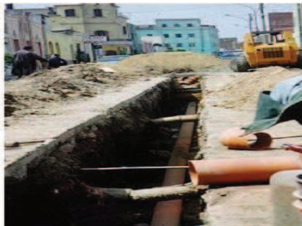
Imagen 3. REHABILITACIÓN DE SISTEMA CON ZANJA- METODO TRADICIONAL
