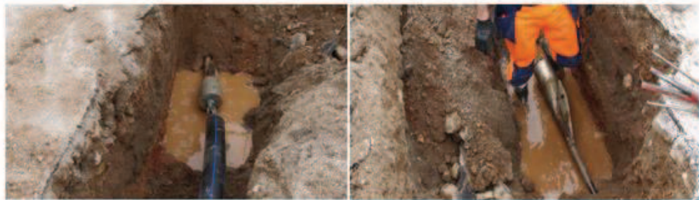
Imagen 13. Fotos reales de instalación de Pipe Bursting.
