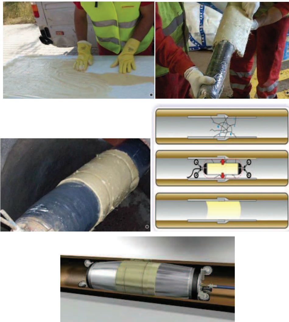
Ilustración 35. TÉCNICA DE MANGA PARCIAL -PACKERS- REHABILITACIÓN
