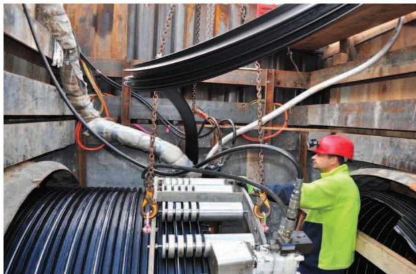
Imagen 24. SPR en el proceso de bobinado
