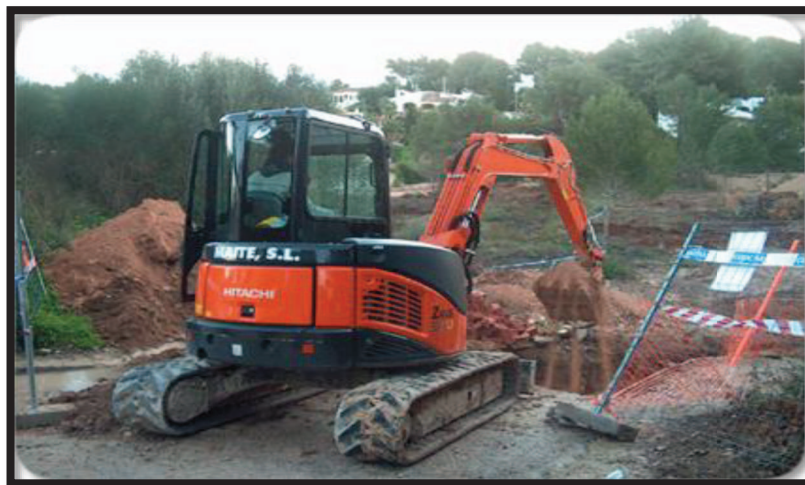
Imagen 2. EXCAVACIÓN EN ZANJA CON MÁQUINARIA
