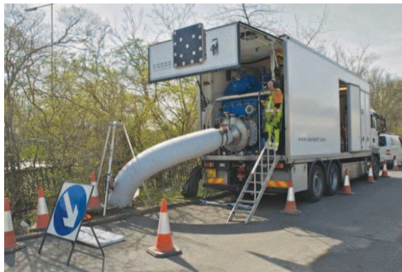
Imagen 28. Instalación y Curado – Caldera de Agua Caliente/ Vapor. CIPP
