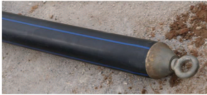
Imagen 12. Tubería PEAD lista para halada e instalada
