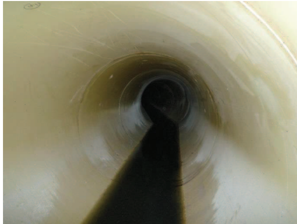
Imagen 14. Relining con PRFV en tubería de gran diámetro.
