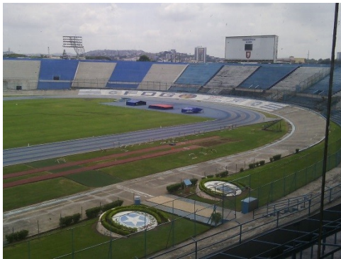
Figura 37: Vista general de los graderíos norte
