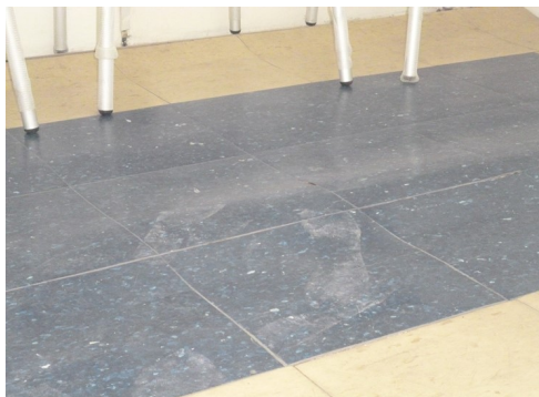
Figura 31: Recubrimiento de Piso
