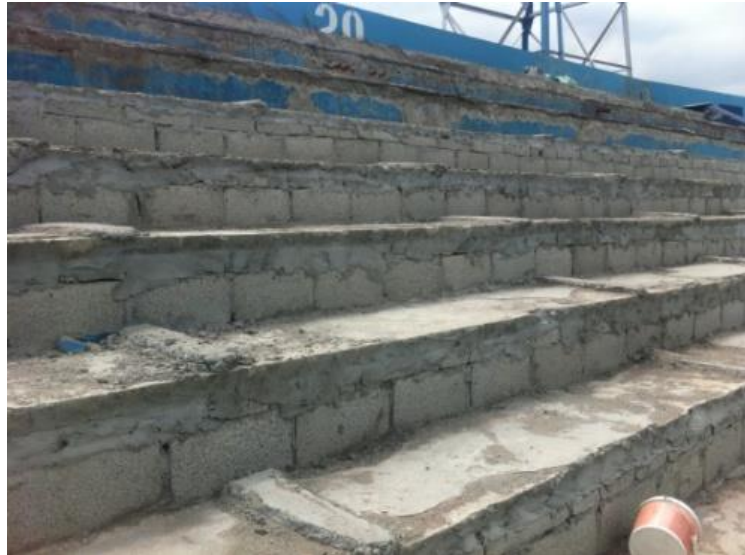
Figura 4: Vista externa Graderíos
