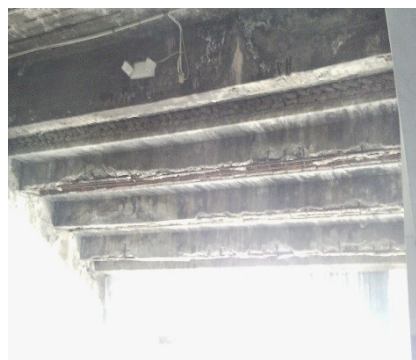
Figura 39: Vista interior de graderíos críticos
