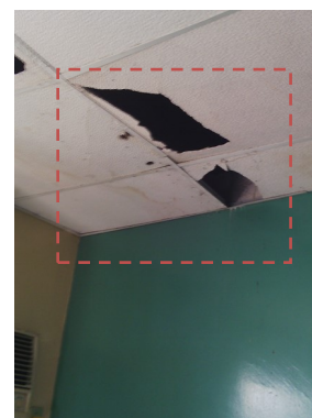
Figura 20: Tumbado dañado
