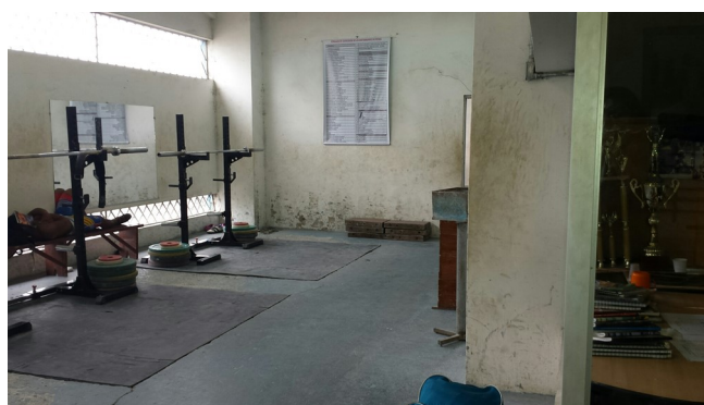
Figura 9: Paredes manchadas (Hombres)
