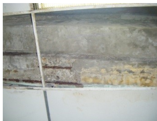
Figura 24: Detalle de viga
