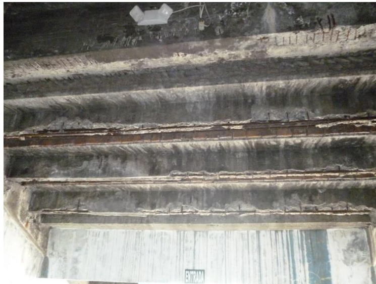
Figura 5: Vista interna Graderíos
