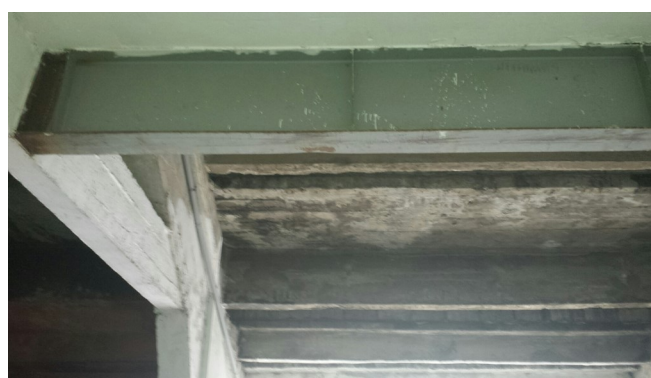
Figura 35: Refuerzo de viga metálica
