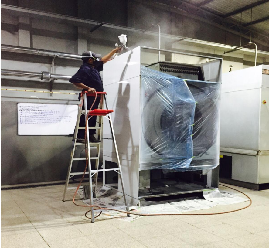
Fotografía 22: Personal de Mantenimiento Preventivo y Correctivo CARNEPAC S.A.
