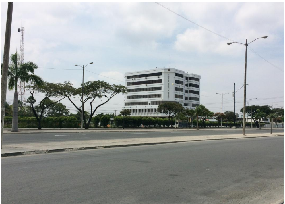
Figura 26: "Vista del lado lateral izquierdo, el establecimiento donde va a estar colocada la OLT"
