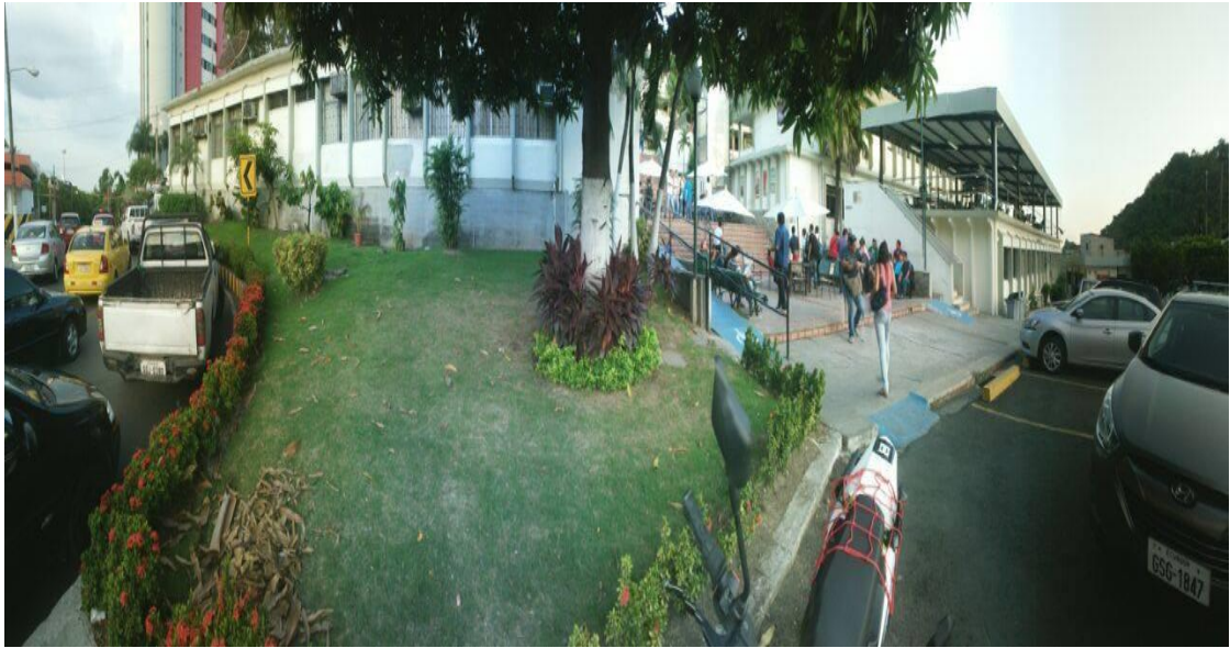
Figura 3.2 Vista de la Facultad Técnica para el Desarrollo.
