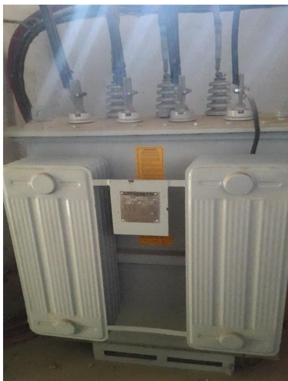
Fig. 25 Transformador 300KVA
