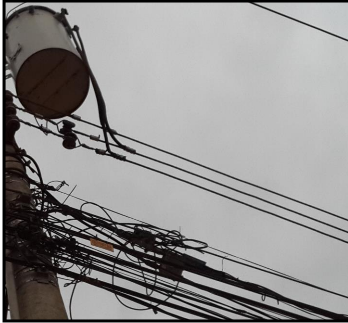
Figura 9. Sistema Secundario de Aluminio Desnudo Fuente: Fotografía de Rainier Romero
