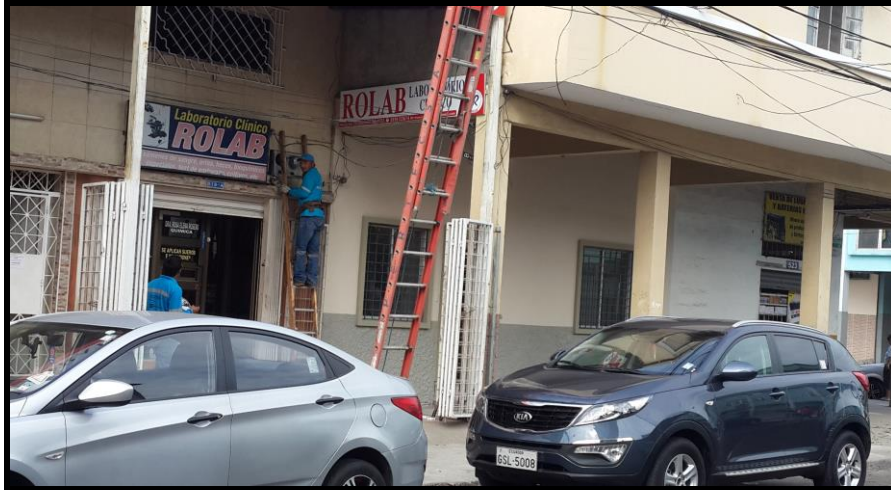
Figura 24. Contratista de CNEL Unidad de Negocio Guayaquil realizando un cambio de medidor.
