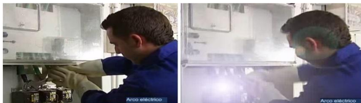
Figura 3.9 Arco eléctrico Fuente: ( http://www.ambientum.com/ )
