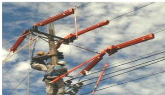
Figura 3.2 Mantenimiento con líneas energizadas Fuente: Empresas Públicas de Medellín E.S.P.
