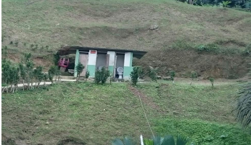
Figura 18 Baños situados dentro del complejo
