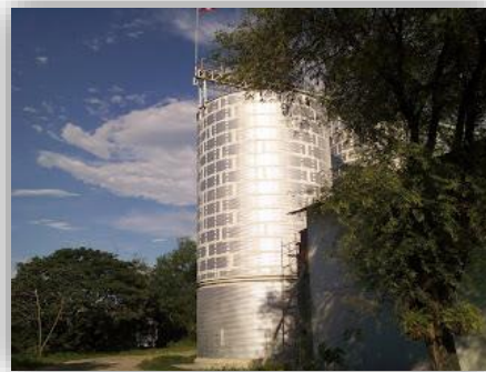
Silos metálicos (1 personas - seguridad) Fuente: Procesadora de Arroz Ecuador S.A.
