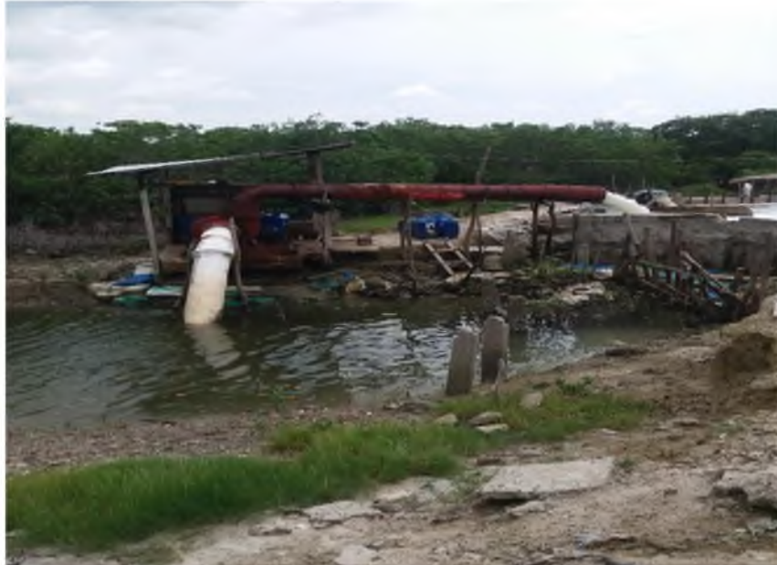
Foto # 1 ESTACION DE BOMBEO
