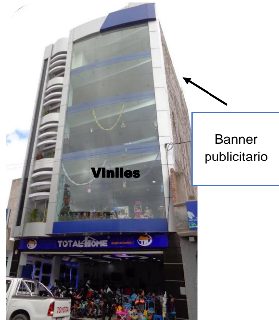
Ilustración 5 Partes externas del edificio
