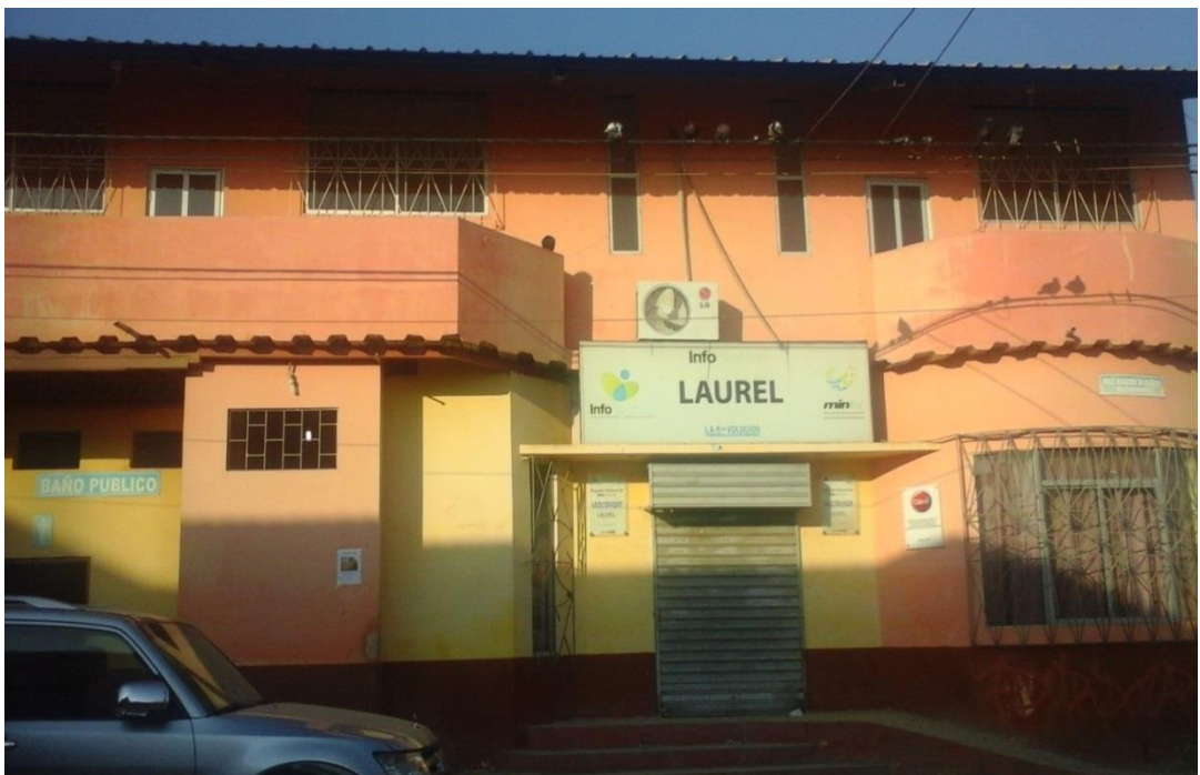
Figura 3. 1: Edificio del Infocentro de El Laurel
