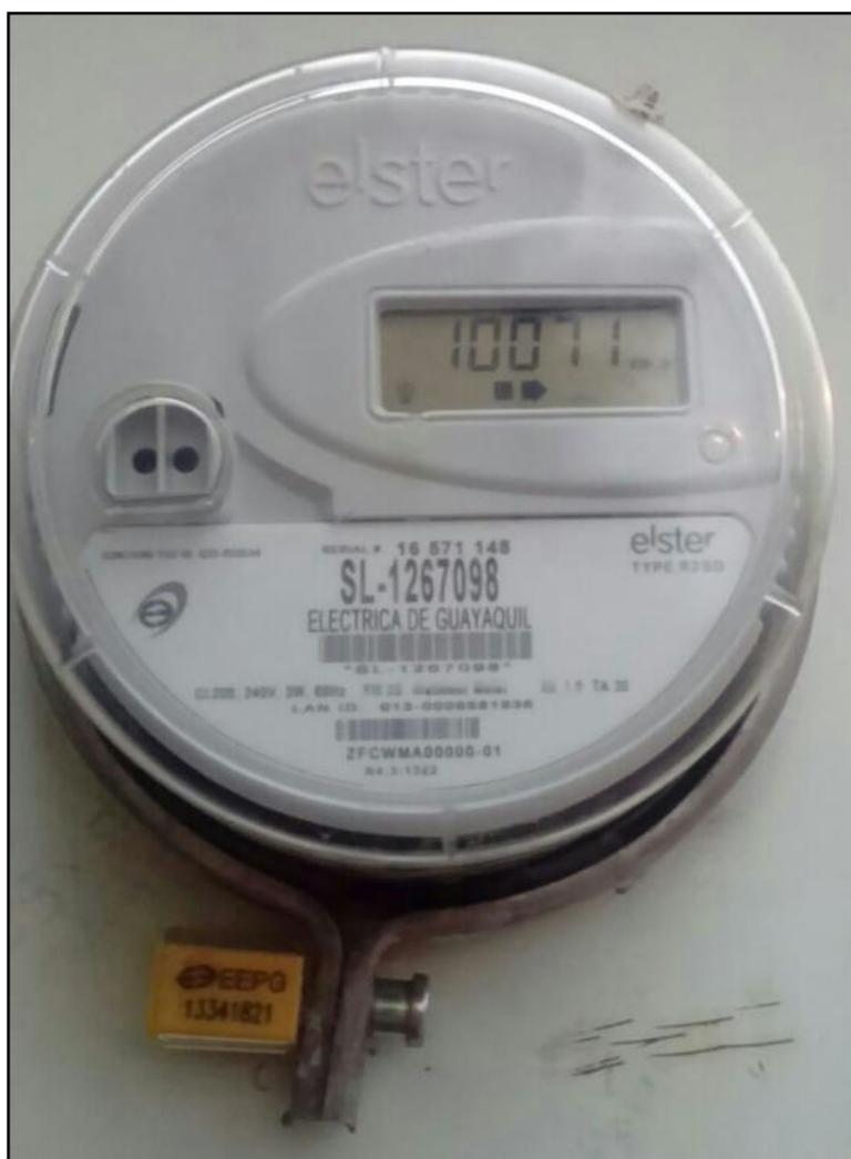
*Figura 25 Medidor inteligente instalado en una residencia de la ciudadela Bosques de la Costa*
