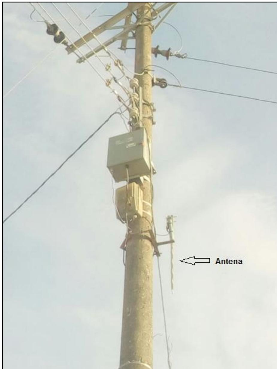
*Figura 26. Medidor inteligente industrial, Indami Cía. Ltda*
