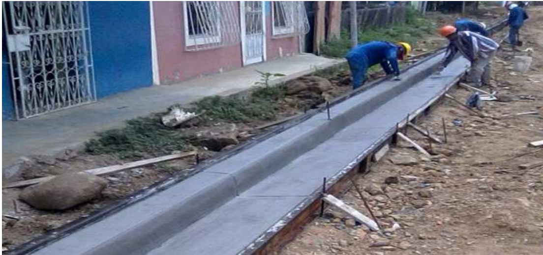
Figura 9 Trabajando en las aceras
