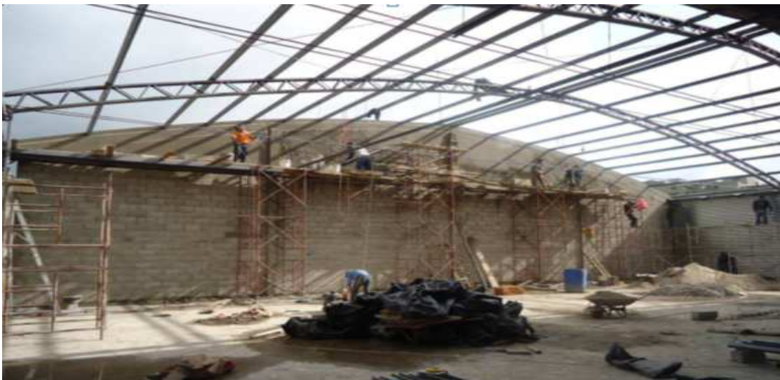
Figura 8 Los constructores trabajando en una obra
