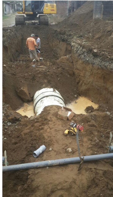
Tubería enterrada de \text{Ø} 1345mm. con pared corrugada (novaloc)
