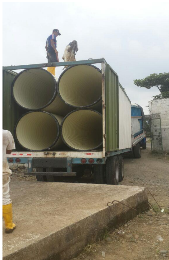
Transportación de la tubería \text{Ø} 1345mm (novaloc)
