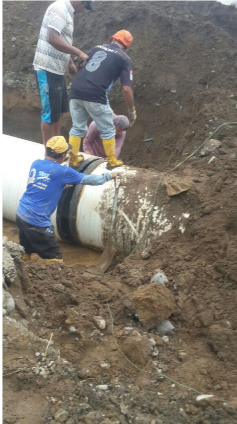
Tubería de diámetro Ø 1345mm. con pared estructurada (novaloc)
