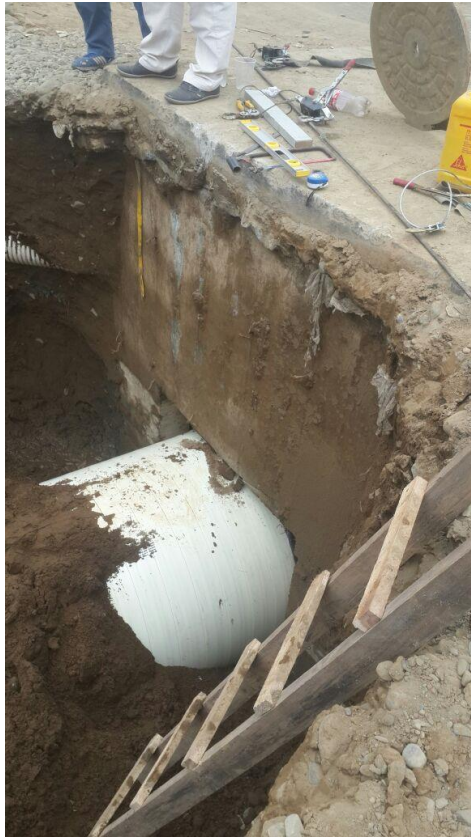
Tubería enterrada de \text{Ø} 1345mm. con pared corrugada (novaloc)
