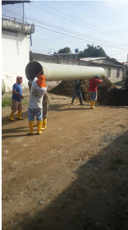
Transporte tubería Ø 650mm.
