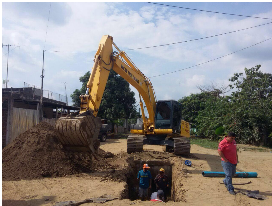
Excavación de zanja sector: Los Chapúlos, Quevedo.
