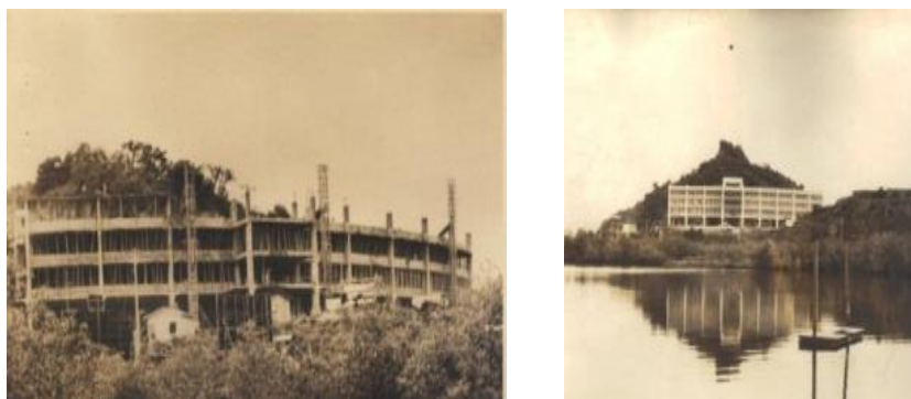
Figura 16 Construcción del edificio principal de la UCSG
