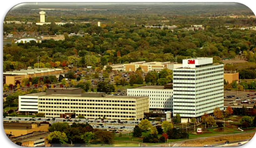
Figura 6. Edificio Matriz 3M
