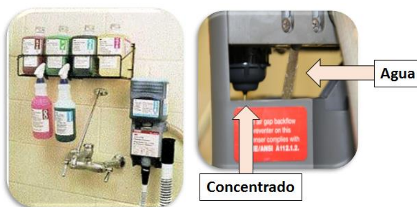
Figura 56. Sistema dilutor de concentrados químicos
