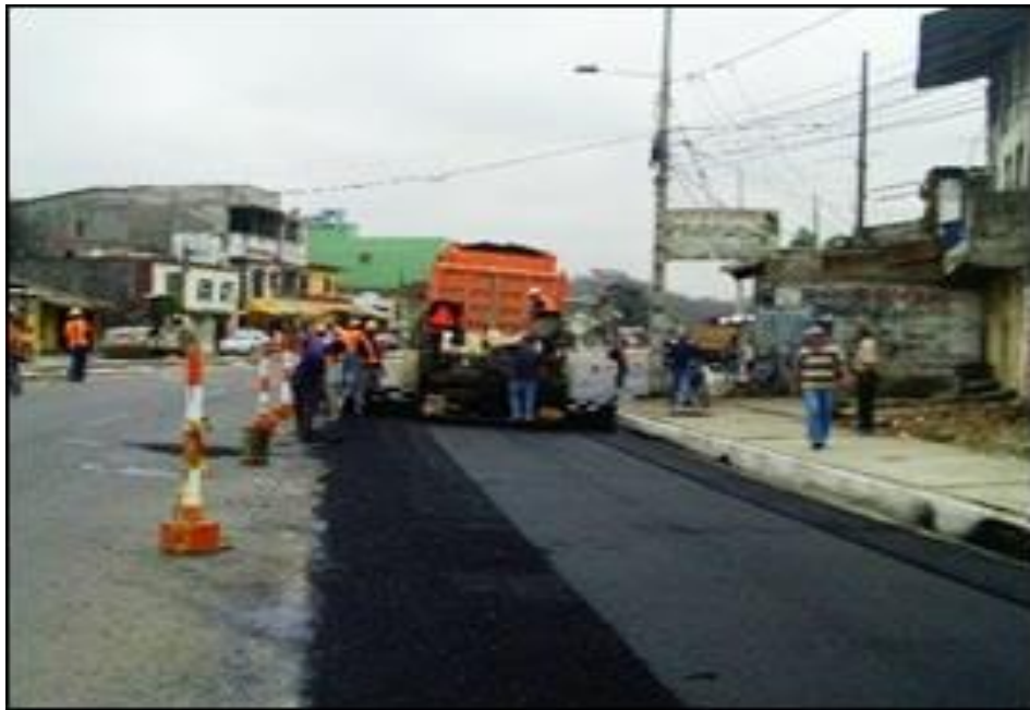
Figura 6. Remoción, Bacheo y Pavimentación Asfáltica tomada de. (Proyectos Generales de Construcción, 2011)
