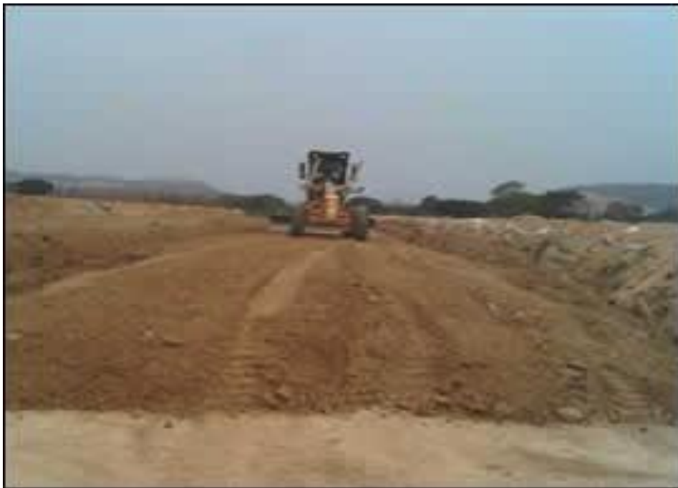
Figura 7. Pavimentación Asfáltica con Carácter Emergente tomada de (Proyectos Generales de Construcción, 2011)
