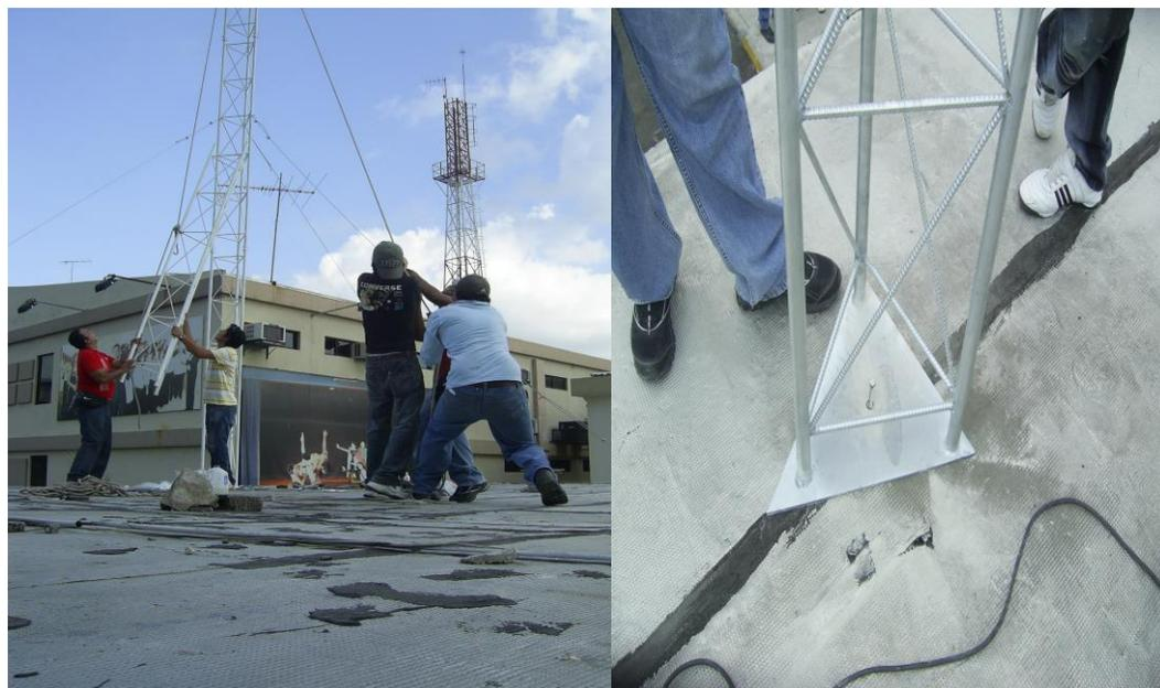
*Tercera parte del levantamiento de la estructura metálica*
