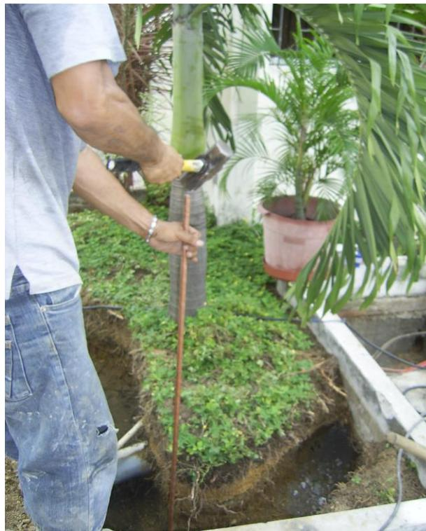
***Fig. 8.4.2. Colocación de Varilla de 6"x 5/8" Cooperweld***
