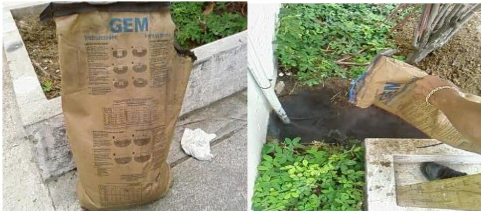
***Figura 6.6.2. Utilización de GEM para mejoramiento del Sistema de Puesta a Tierra para el pararrayos implementado en la salas de cómputo de la Facultad Técnica.***
