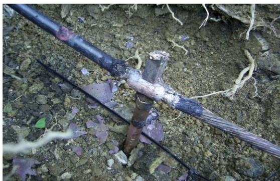
*Figura 6.8. Conector de Puesta a Tierra del tipo Soldadura Exotérmica en los exteriores de la Sala de Cómputo.*
