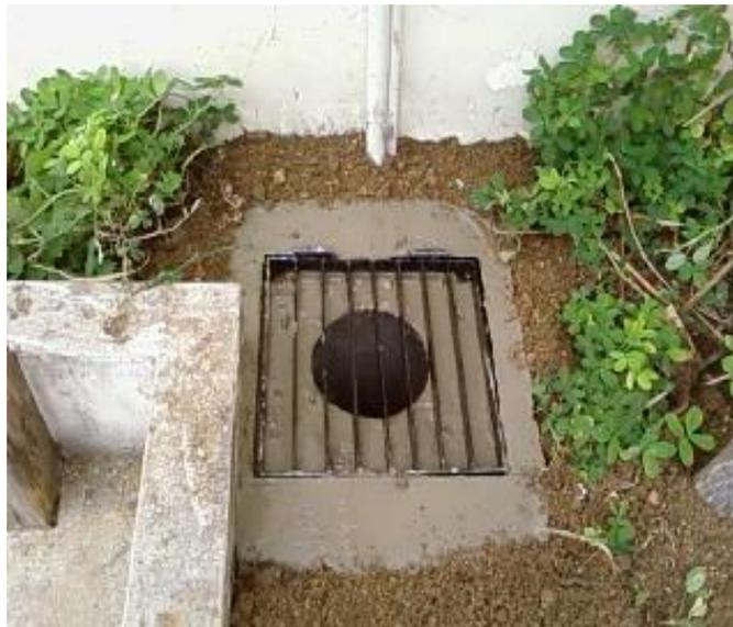
*Fig. 8.4.3. Caja de Registro usada en el sistema de puesta a tierra*
