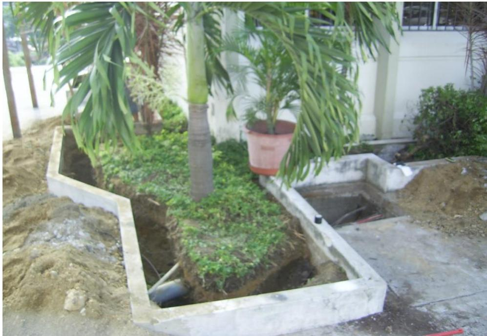
*Figura 6.5.3 (a) Excavación de la Zanja para enterrar la Varilla Copperweld en las Salas de Cómputo de la Facultad Técnica*
