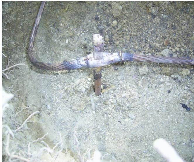
***Figura 6.9. (d) Conector de la Puesta a Tierra implementado en los exteriores de la Sala de Cómputo.***
