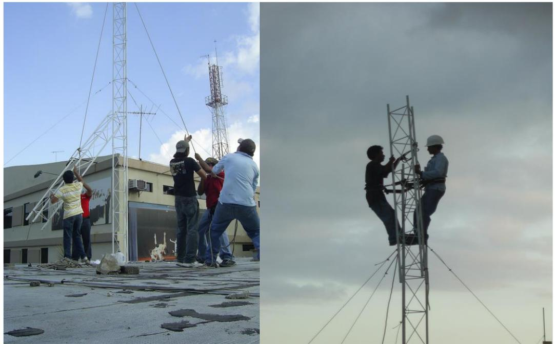
*Fig. 8.4.4. Armado de la Torreta de Viento Galvanizada*
