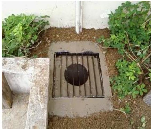
*Figura 6.6.3. (a) Caja de Registro usada en el sistema de puesta a tierra*
