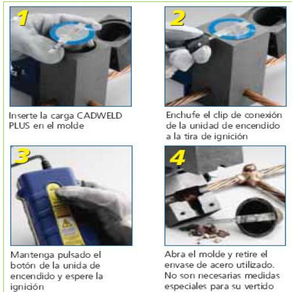
***Figura 6.12. (c) Pasos a seguir para realizar la Soldadura Exotérmica***
