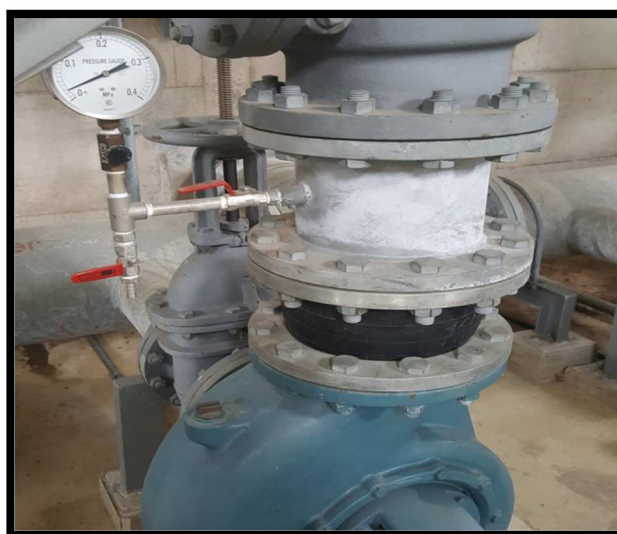
Figura 4. 37: Bomba de Transmisión - retro lavado - lavado superficial Fuente: EMRAPAH
