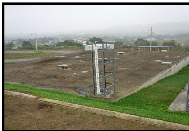
Figura 3. 9 : Tanques de reserva Fuente: EMRAPAH
