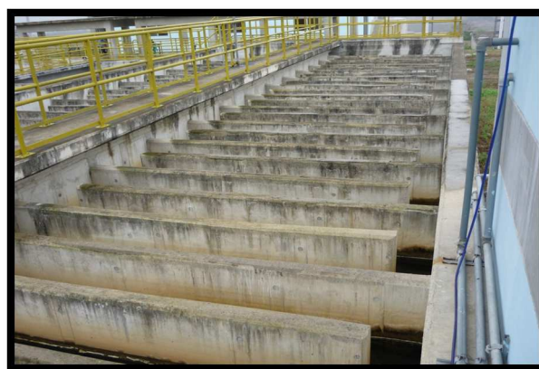
Figura 3. 6 : Área de Floculación Fuente: EMRAPAH
