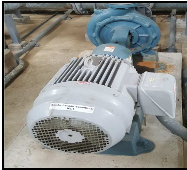
Figura 4. 38: Bomba de Transmisión - retro lavado - lavado superficial Fuente: EMRAPAH
