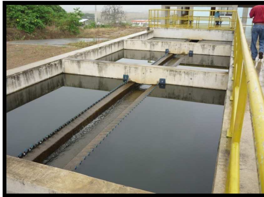
Figura 3. 7 : Área de Sedimentación Fuente: EMRAPAH
