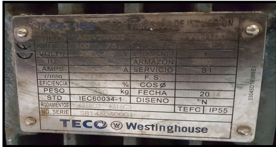
Figura 4. 35: Placa de Bomba Fuente: EMRAPAH
