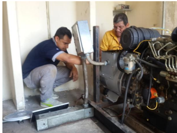
Figura 3.26 Parte electrogénea acoplada El autor 2016
