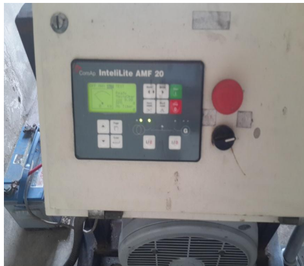
Figura 3.27 Arranque del generador El autor 2016
