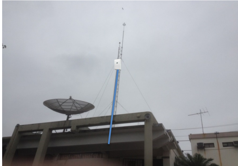
Figura 3. 15: Montaje de la antena en la torreta existente. Elaborado por: Autor
