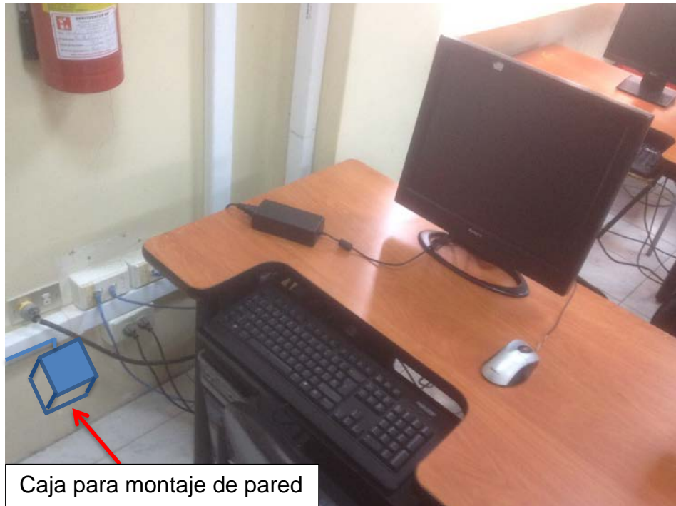
Figura 3. 18: Caja para montaje de pared del conector RJ45 del cable FTP. Elaborado por: Autor
