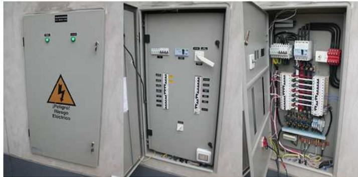
Figura 2. 4: Tablero de energía de una RB.
