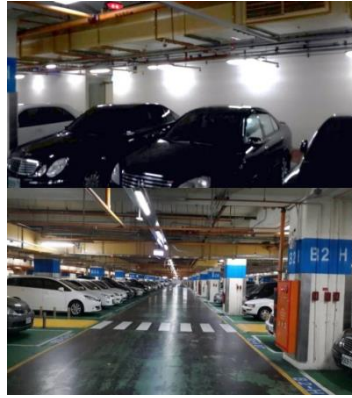
Figura 2. 10: Estacionamiento con el sistema indicador de búsqueda de vehículos y luces Fuente: (Chang et al., 2016)
