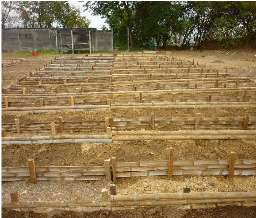
Foto 1. Construcción de camas
