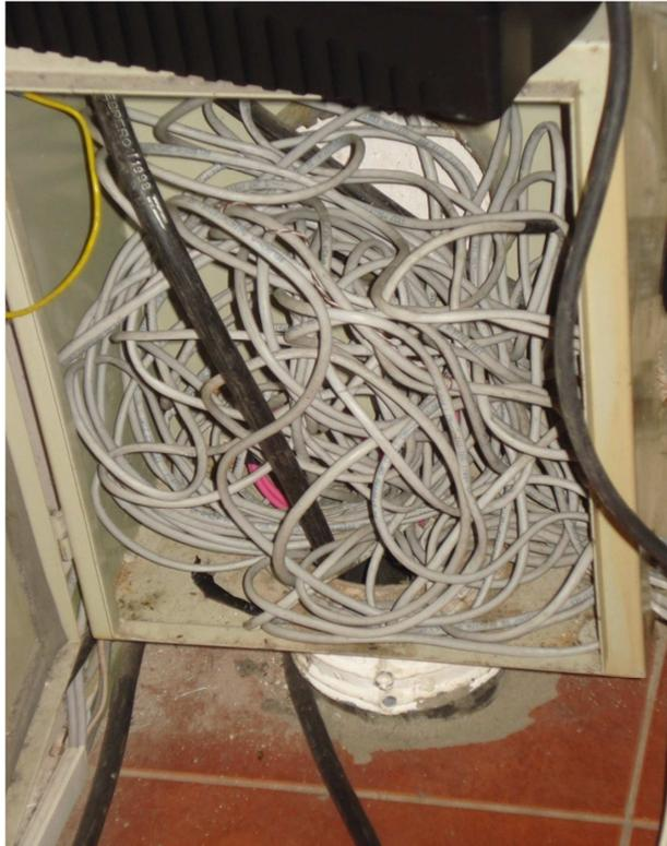
**Figura 3.3 Vista del rack antes de su reestructuración**
