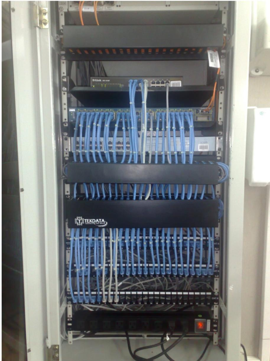
**Figura 3.17 Rack terminado y listo para su funcionamiento
