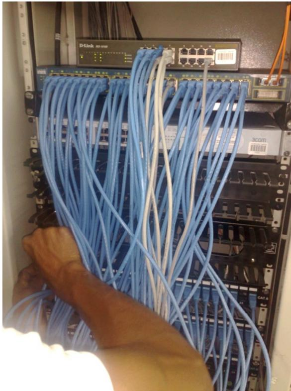
**Figura 3.14** Instalación de los patch cord
