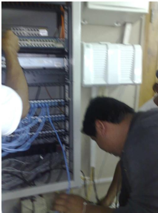
**Figura 3.13 Instalación de los *patch cord*.**
