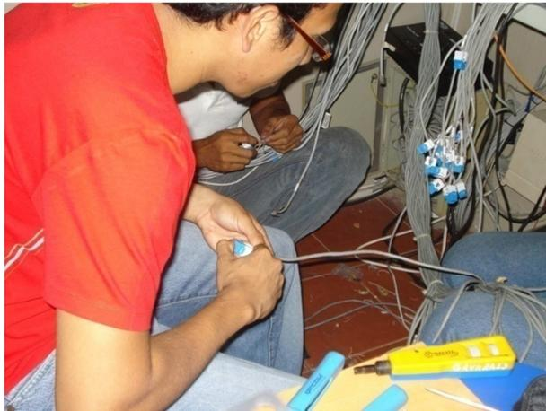
**Figura 3.8 Procedimientos del ponchado del *Jack* de datos**
